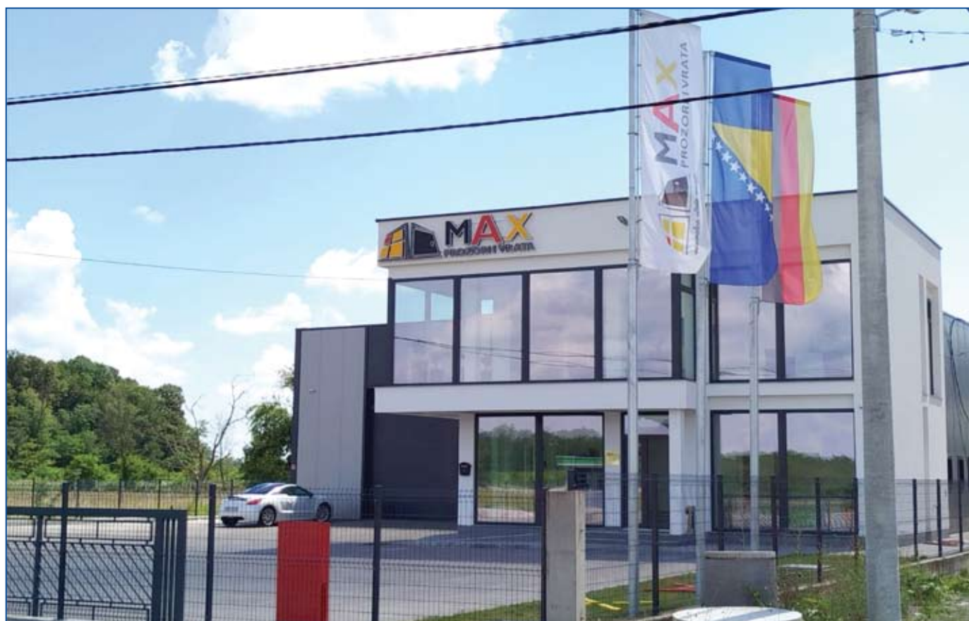
Savremen poslovno-proizvodni objekat
